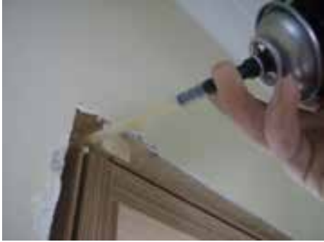
12. AŞAMA: 12.1. Kapılar sabitlendikten sonraki aşama, köpük aşamasıdır.
