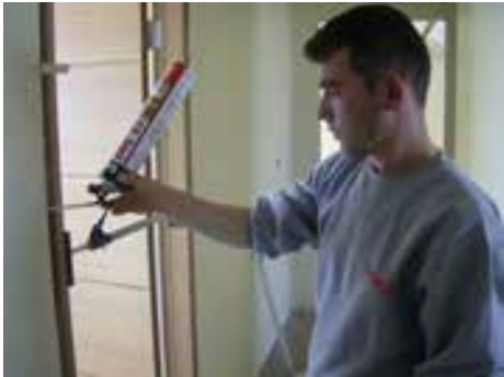
12. AŞAMA: 12.2. Kasa ve duvar arasında köpük sıkılmaktadır.
