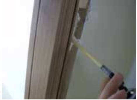
12. AŞAMA: 12.3. Köpük kullanılıncasında ki amaç kapının daha rahat sökülüp takılması, sağlamlaştırılması ve yerinden oynamasını engellemektir. Estetik açıdanda daha güzel görünmesini sağlar.
