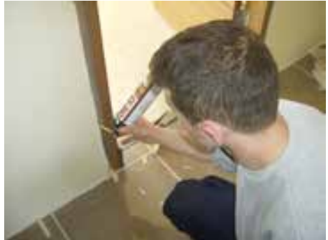
12. AŞAMA: 12.3. Köpük kullanılıncasında ki amaç kapının daha rahat sökülüp takılması, sağlamlaştırılması ve yerinden oynamasını engellemektir. Estetik açıdanda daha güzel görünmesini sağlar.
