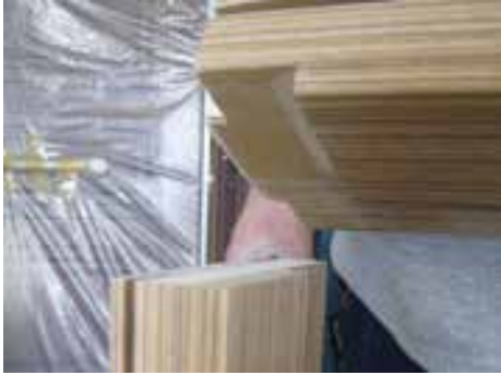
5. AŞAMA: 5.1. Üst ve yan kasa 5x70 ebatlarında vida ile birleştirilir.
