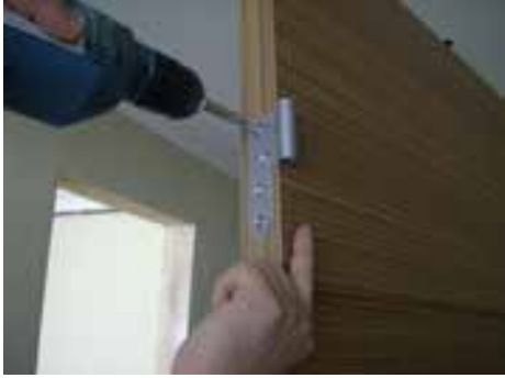
4. AŞAMA: 4.1. Yan kasa ve kanat tarafına menteşeler vidalanır.
