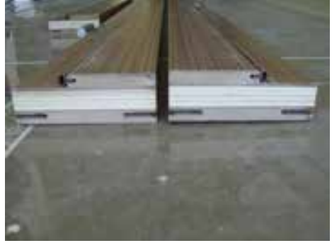
3. AŞAMA: 3.1. Kasa kalınlığı 42mm dir. 2. resimde kasa detayı ve bulunan yangın fitili görülmektedir.
